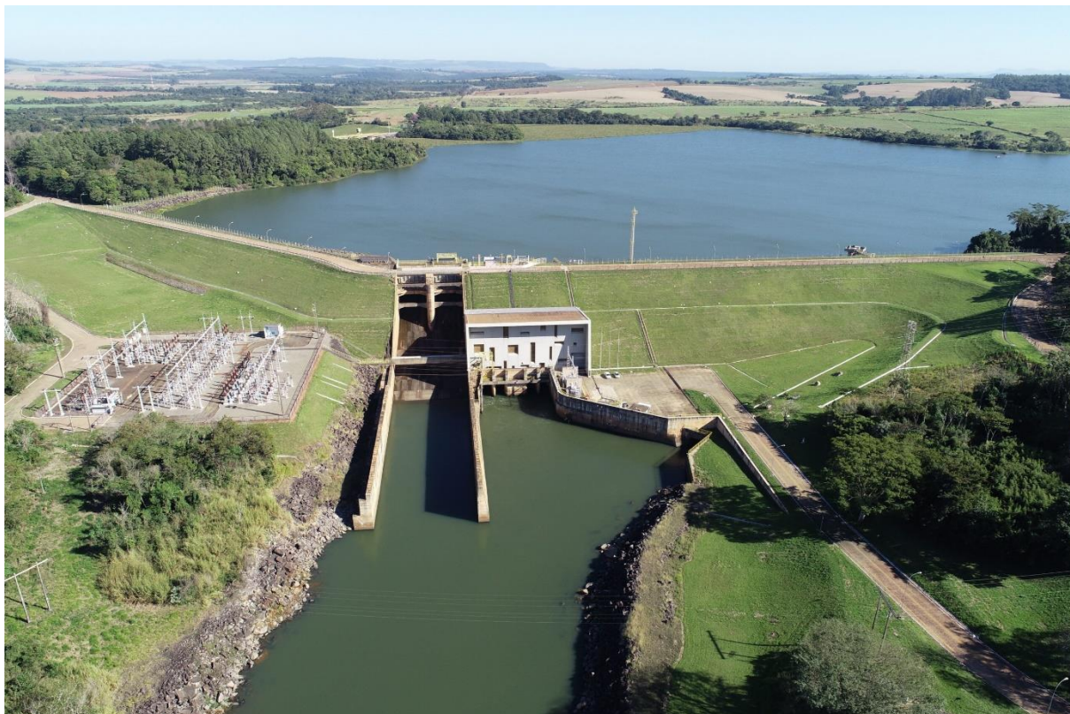
Figura 1 – Vista geral da barragem da UHE Limoeiro
