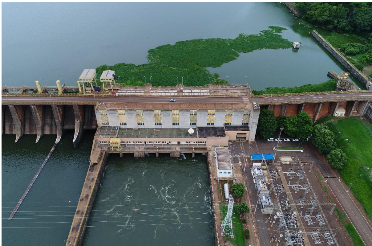
Figura 1 – Vista geral da barragem da UHE Bariri
