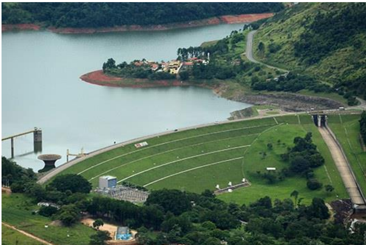
Figura 1 – Vista geral da barragem da UHE Caconde
