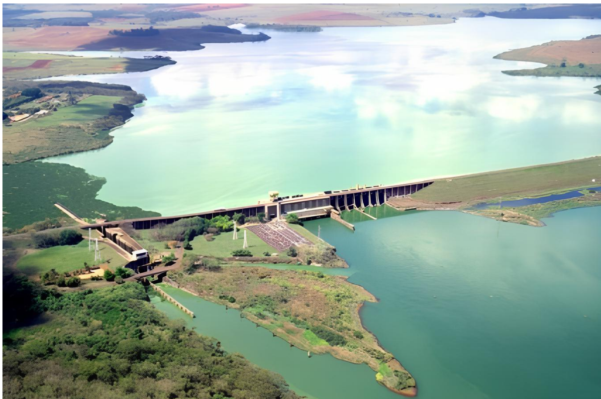
Figura 1 – Vista geral da barragem da UHE Ibitinga
