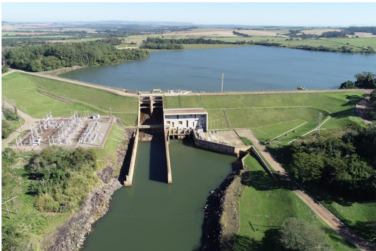
Figura 1 – Vista geral da barragem da UHE Limoeiro
