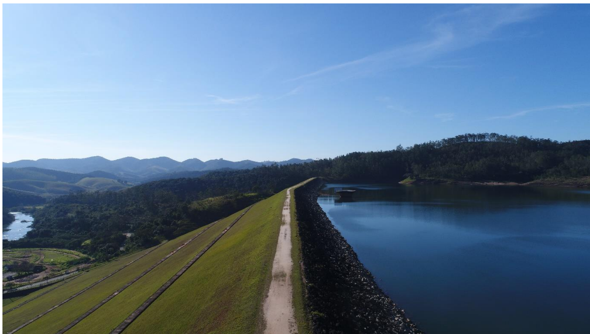
Figura 1 – Vista geral da barragem da UHE Paraibuna
