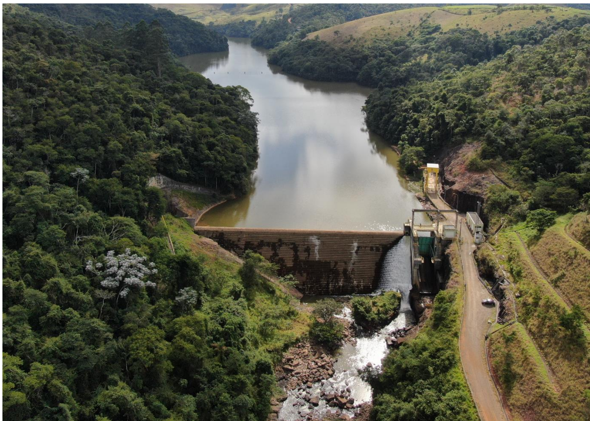
Figura 1 – Vista geral da barragem da UHE Picada
