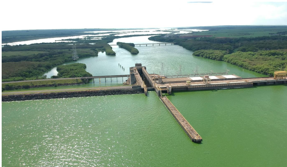
Figura 1 – Vista geral da barragem da UHE Promissão
