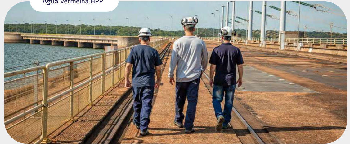
Água Vermelha HPP
